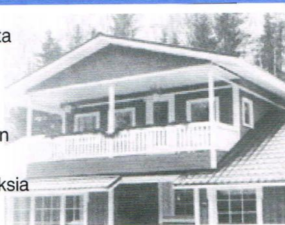
Kuvassa talon yläkerta pystyhirrestä rakennettuna
